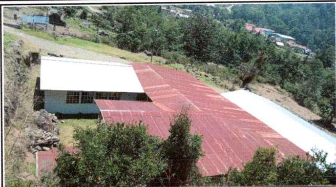
Foto1: Sustitución de lámina, por lamina troquelada aluzinc calibre 26 en Modulo 1
