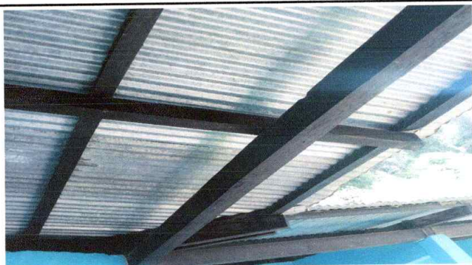
Foto 3: Sustitución de estructura de soporte de madera, por metal del Modulo 1
