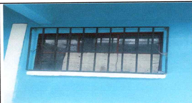
Foto 6: Sustitución de balcones de metal en Modulo 1
