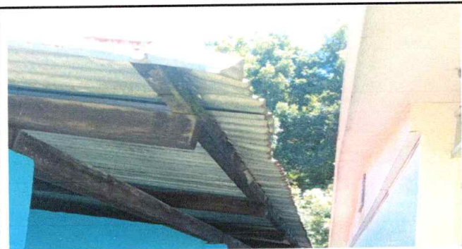
Foto 5: Sustitución de canal de metal en la parte frontal del Modulo 1
